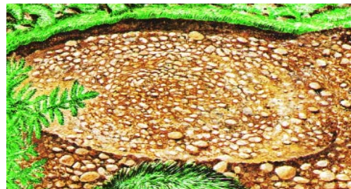
Nach Bestimmung von Standort und Form des Teiches Rasen abtragen. Das Loch ausheben, den Erdaushub z. B. als Erdwall um den Teich aufschütten.
