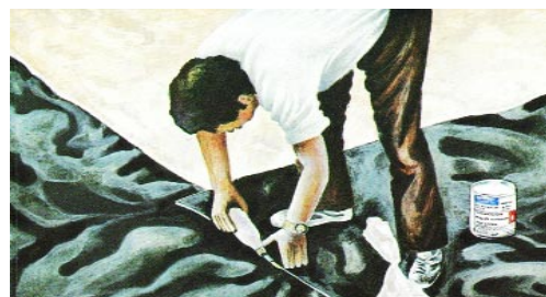
Die Mipoplast® Teichbahnen verlegen.
