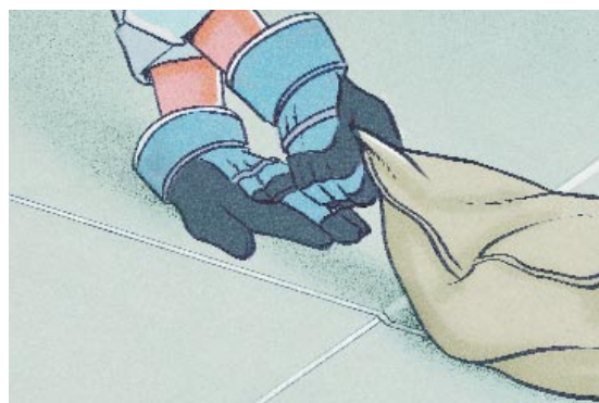
Gleichmäßiger Andruck durch Sandsack (Polyethylen-schlauch)
